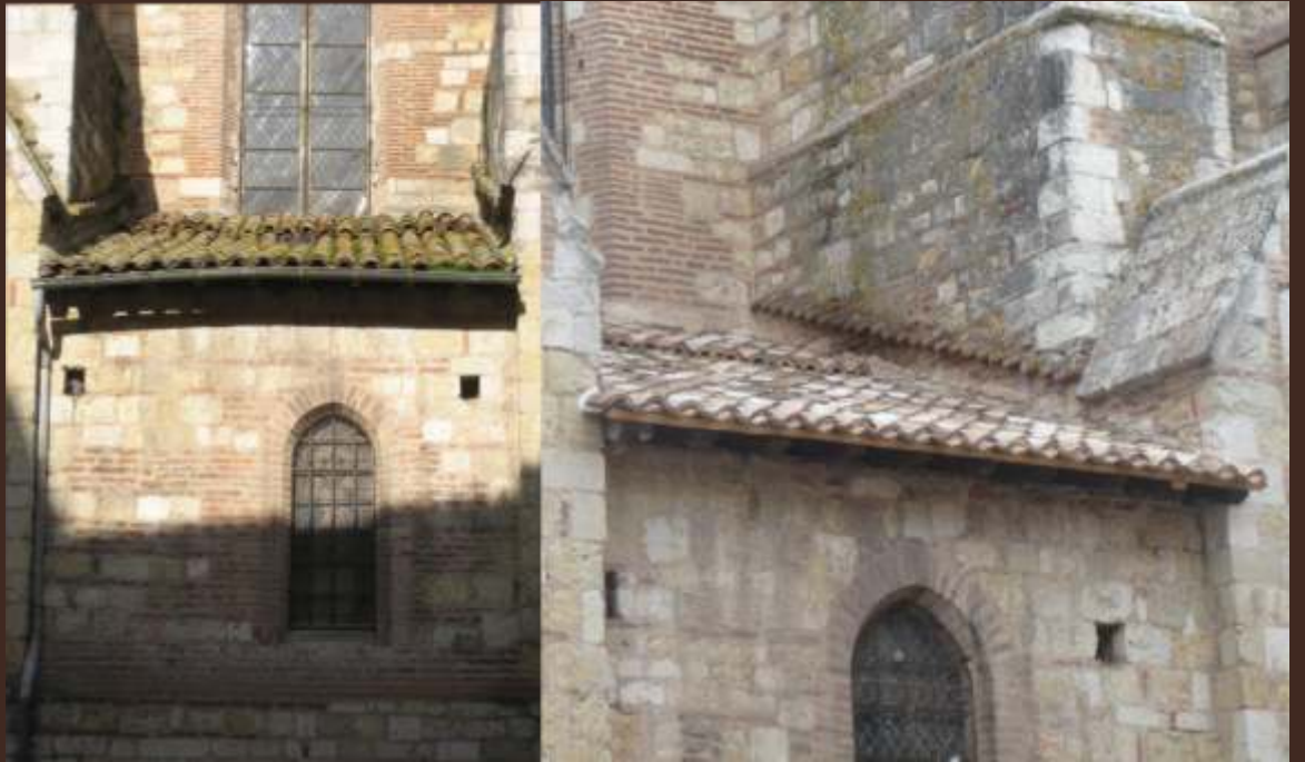
Moissac - l'abbatiale, entretien des couvertures des chapelles Sud
