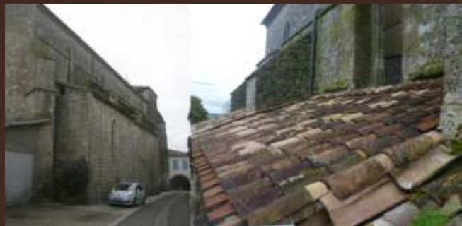
Castelsagrat - l'Eglise, la charpente et les couvertures bas-côtés
